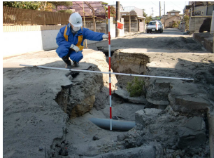
↑植田町根小屋 下水管露出状況
